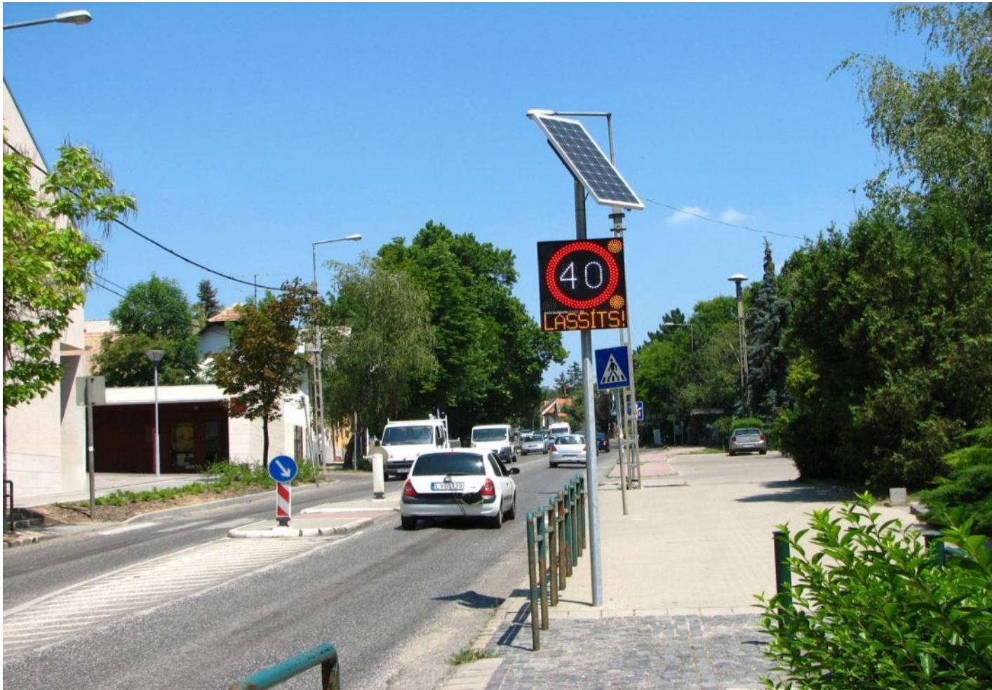
Budakeszi, 8102. j. út, sebességkorlátozásra figyelmeztető berendezés
